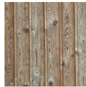
Bardage à couvres joints
